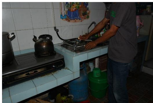
▲生成されたメタンガスをパイプで家の中まで引き取られて利用しています。
