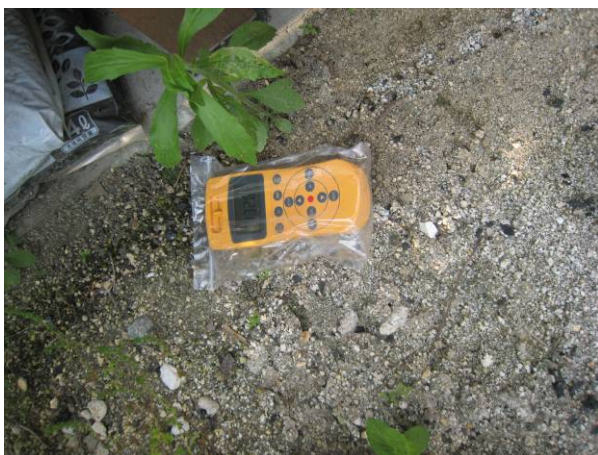
写真2 物置屋根の下の雨垂れ跡
